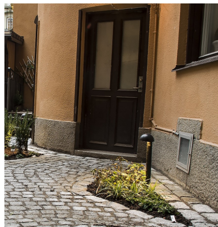
Utmed fasad och längs ytterkant läggs två rader storgatsten.
