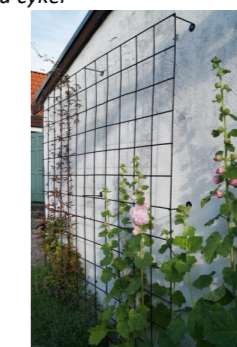
Väggspaljé av obehandlad armeringsnät.
